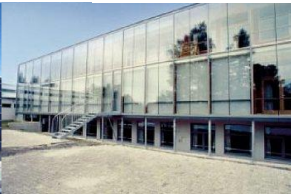
Sanierung der Volksschule Grafenschlag, Zwettl
