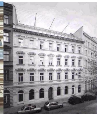
Sanierung der Männerwohnheim der Heilsarmee, Wien
