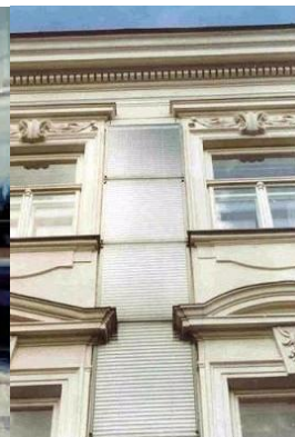
Sanierung der Standardhauses aus der Gründerzeit, Wien
