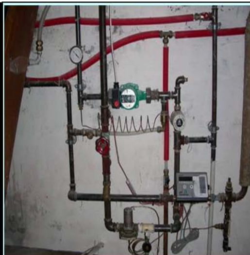
Fjernvarmeanlægget er et "Direkte anlæg", altså uden fjernvarmeveksler og tab.
