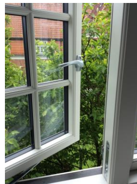
Udskiftning af vinduer
