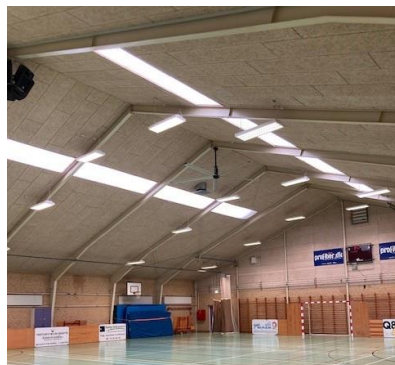
LED belysning og loftventilatorer
