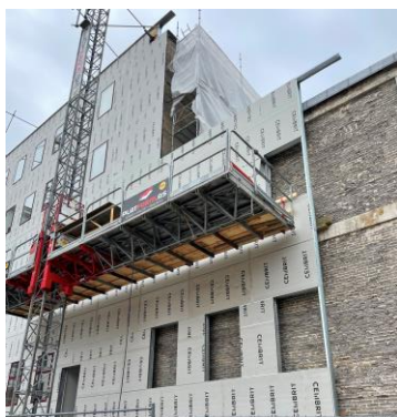
Forbedring af klimaskærm ved efterisolering.
