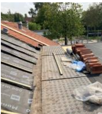
Efterisolering ved tagudskiftning
