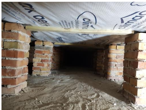
Efterisolering af krybekælder
