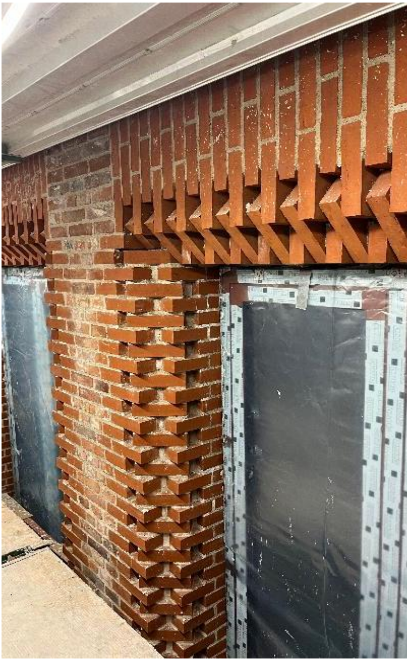
Kombination af genbrugsteglen og nye tegl. For at sikre konstruktiv styrke er der anvendt nye tegl
