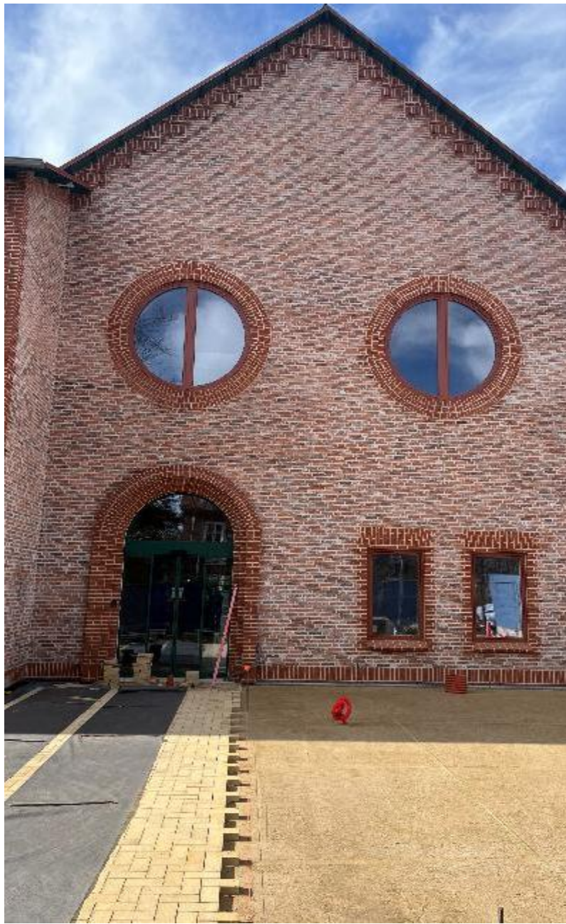
Kombination af genbrugsteglen og nye tegl. For at sikre konstruktiv styrke er der anvendt nye tegl
